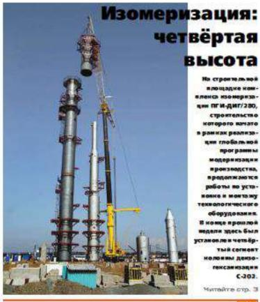
На строительной площадке комплекса изонеризации ПГИ-ДИГ/280, строительство которого вачато в ранках реализации глобальной программы модериизации производства, продолжаются работы по установке и монтажу текнопогического оборудования. В конце проилой недели здесь был установлен четвёртый сегмент ноложны декзогенсамизации C-202.
